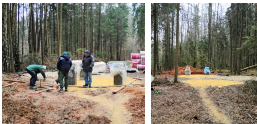
Рисунок 5.5 — строительная площадка абсолютного (слева) и вариационного (справа) павильонов
